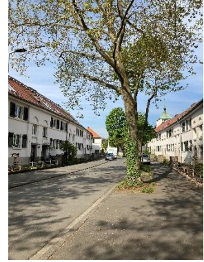
Illigweg 2-28, 3-27 Einbau von Dachflächenfenstern
