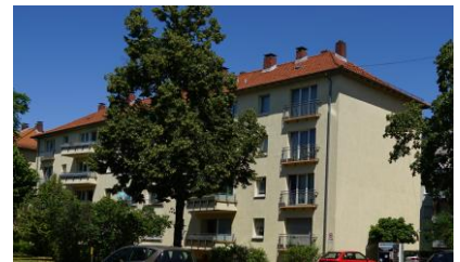
Dolivostr. 1-7, Bismarckstr. 65-67 Dachbodendämmung
